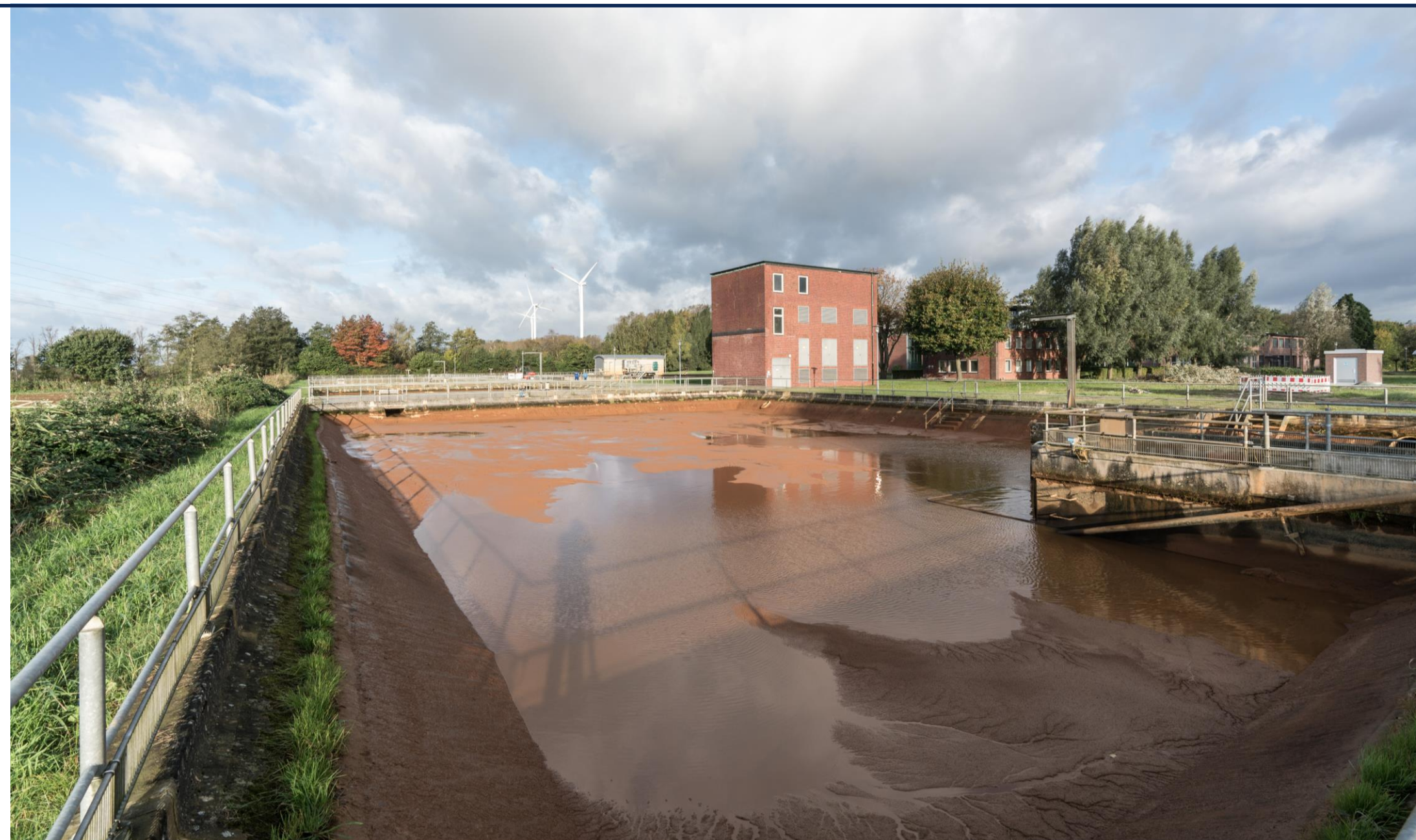
Filterspülwasser-Becken (Quelle: Hamburg Wasser)
